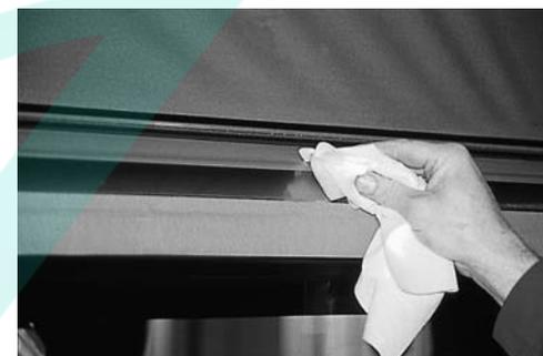
Die Strangdicke wird so gewählt, dass beim Aufdrücken der TOP-RAIL auf den Untergrund oben und unten der Kleber ein wenig hervortritt, um eine gute Abdichtung zu gewährleisten.
